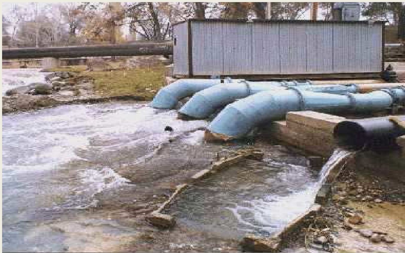
Действующая микроГЭС в пригороде г.Бишкек, мощность 66кВт
